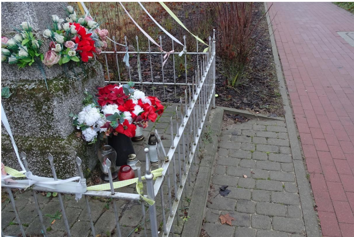
Fot. Waldemar Brzostek grudzień 2024 ( utwardzenie terenu wokół kapliczki, kostka betonowa )
