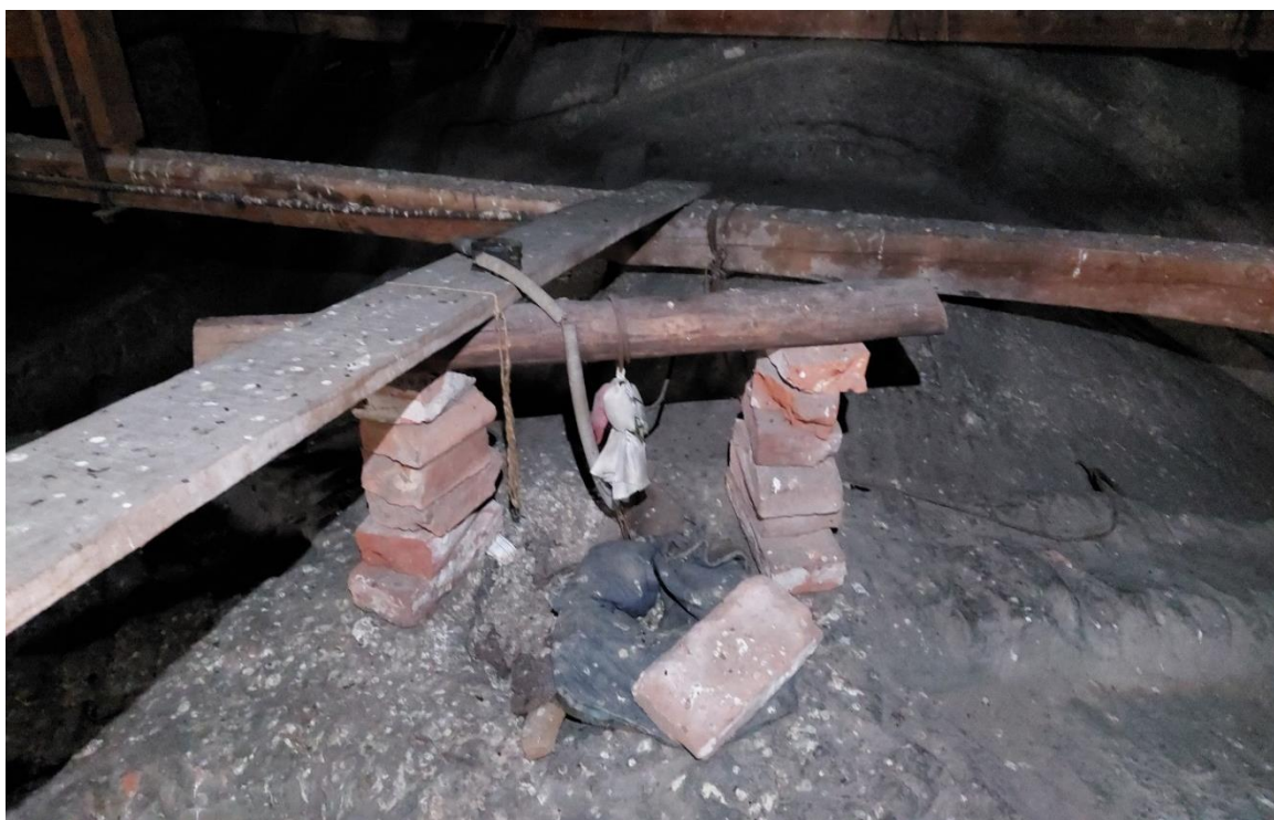
Fot. 17. Kolejne amatorskie rozwiązania konstrukcyjne wspierające się o sklepienia Fot. Paulina Zalewska
