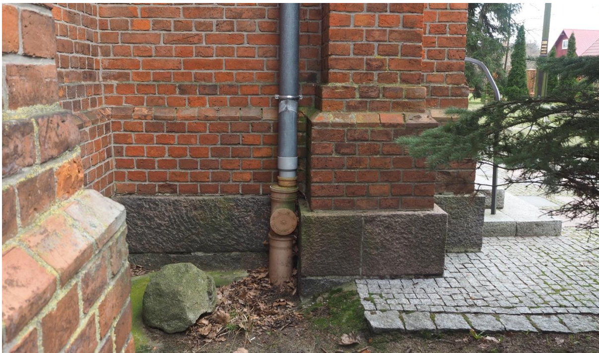
Fot. 10. System rur spustowych odprowadzających wodę deszczową – niespójny materiałowo i kolorystycznie. Fot. Paulina Zalewska
