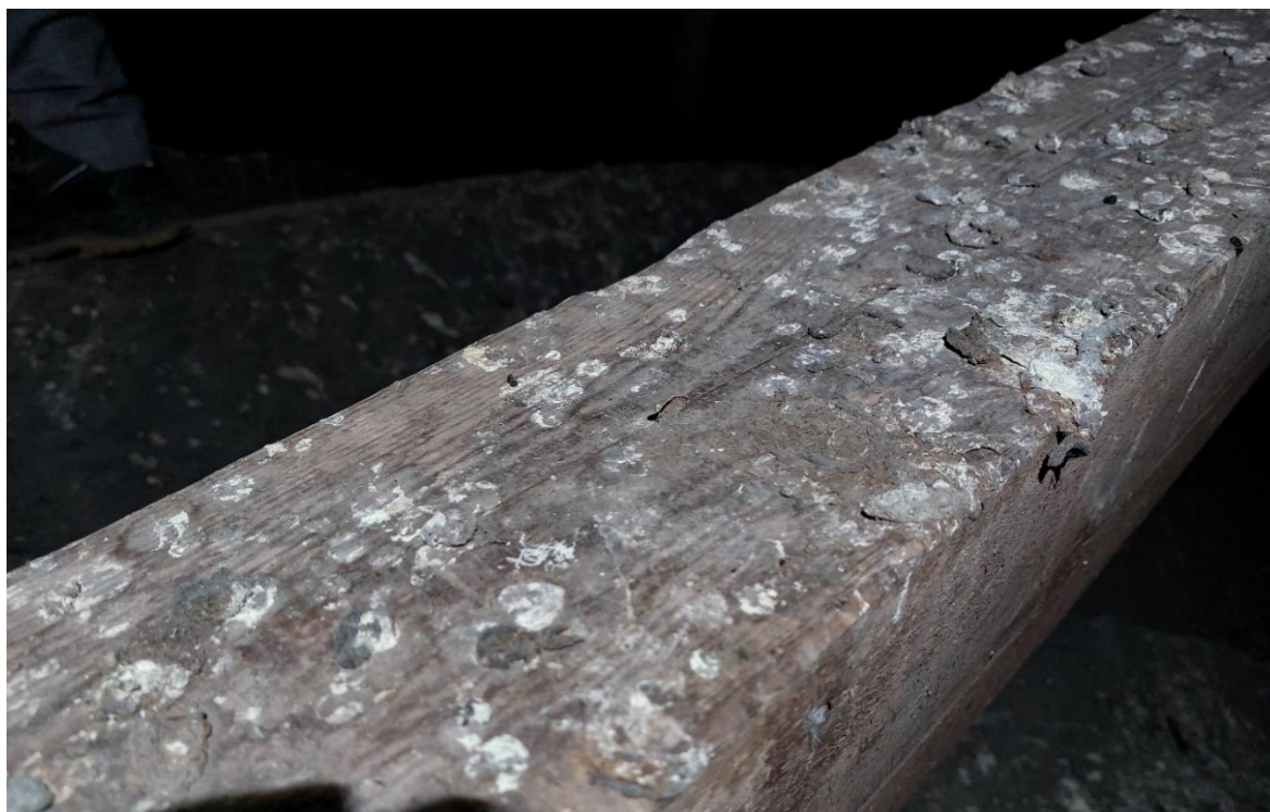
Fot. 21. Otwory wylotowe w drewnie świadczące o porażeniu przez owady-drewnojady. Fot. Paulina Zalewska
