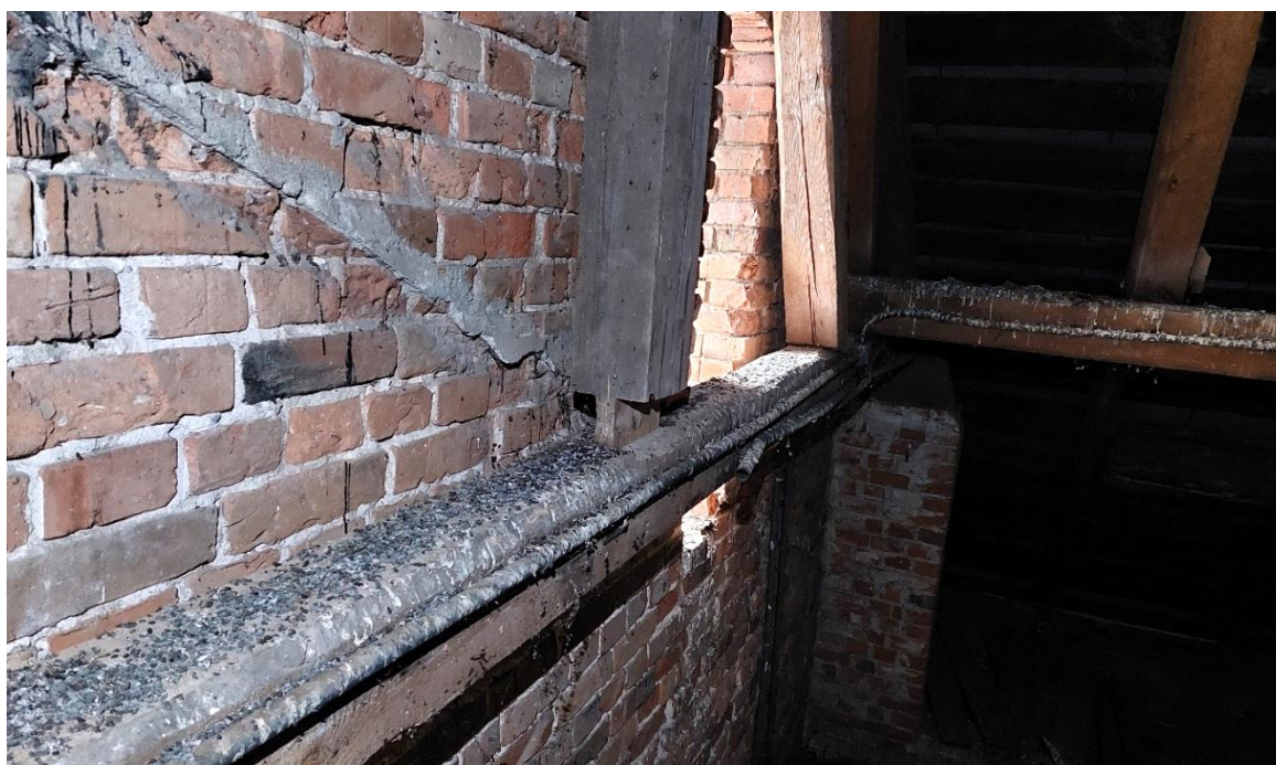
Fot. 19. Inny element więźby wypięty z zamku ciesielskiego. Fot, Paulina Zalewska
