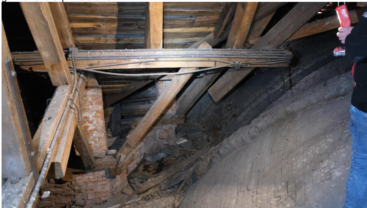
fot. nr 5 widok na podparcie krokwi kosowej na skrzyżowaniu naw z zauważalnym ugięciem wysuniętej wspornikowo płatwi.
