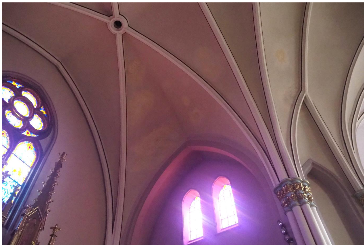
Fot. 28. Plamy i przebarwienia na sklepieniach Kościoła – transept. Fot. Paulina Zalewska
