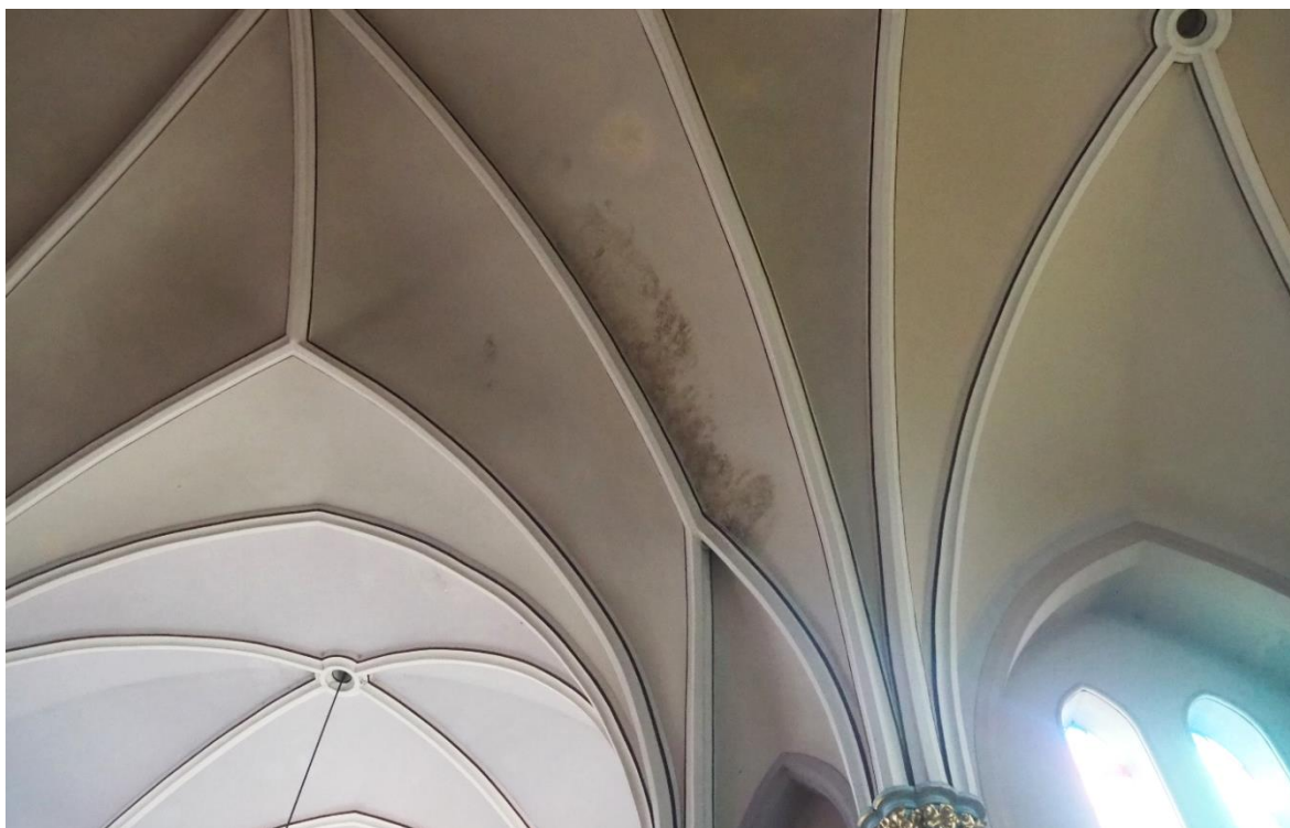
Fot. 26. Zaplamienia na sklepieniach od strony wnętrza Kościoła. Fot. Paulina Zalewska
