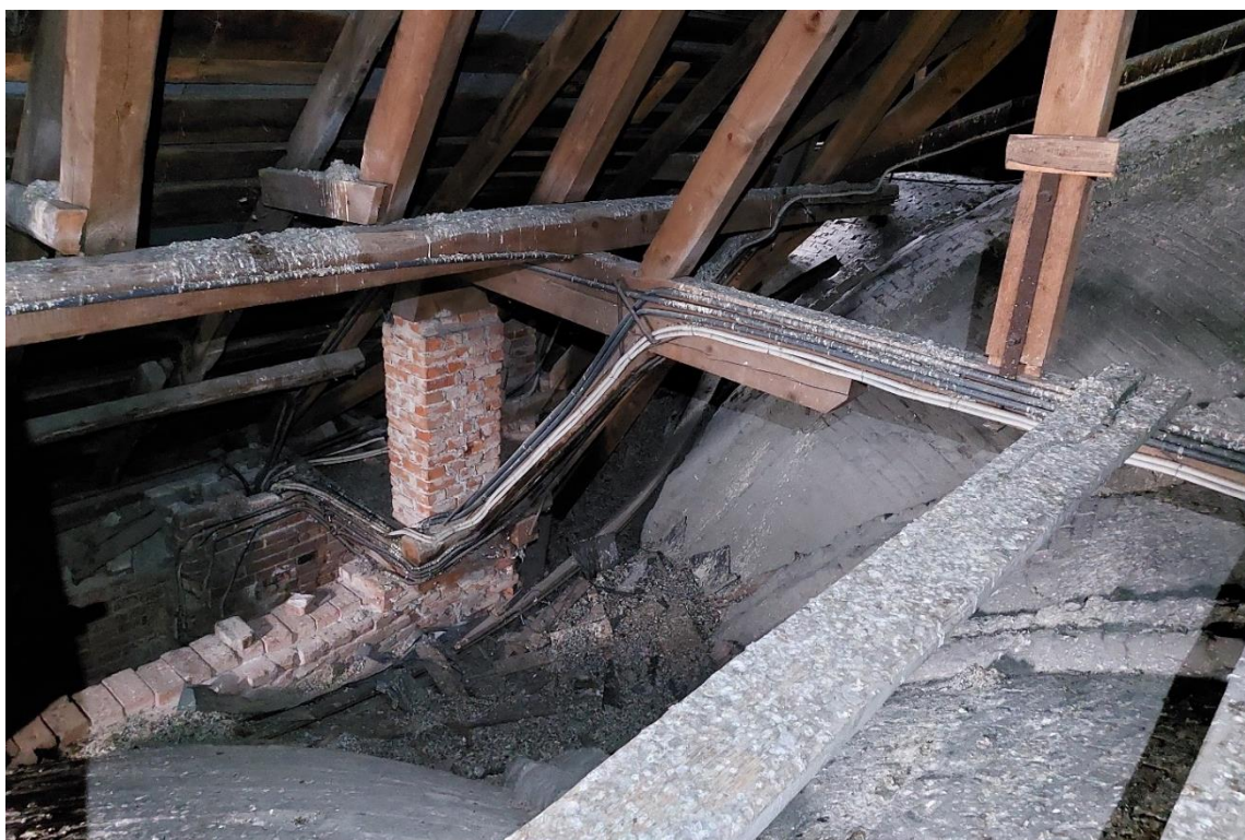
Fot. 23. Stan zanieczyszczenia poddasza przez ekskrementy gołębi. Fot. Paulina Zalewska
