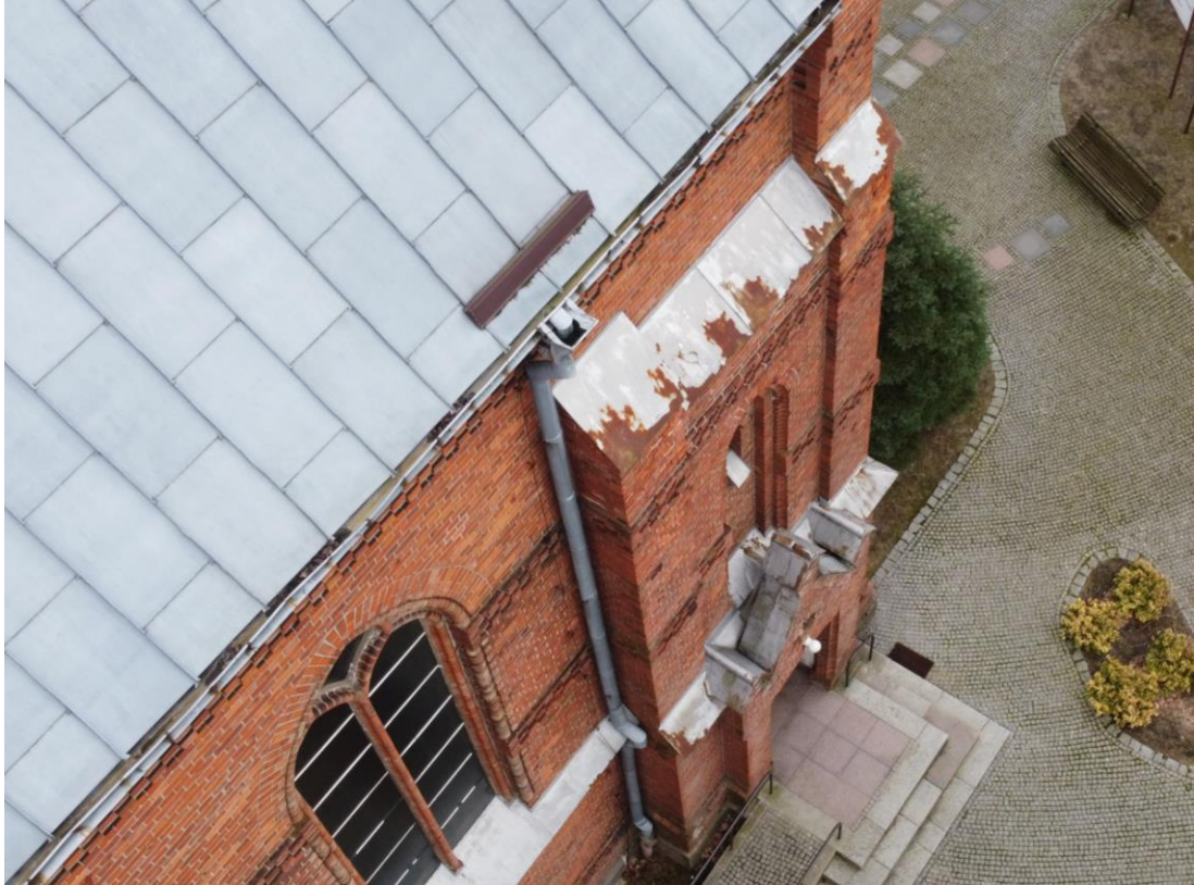
fot. nr 7 widok korozji obróbek blacharskich na przyporach
