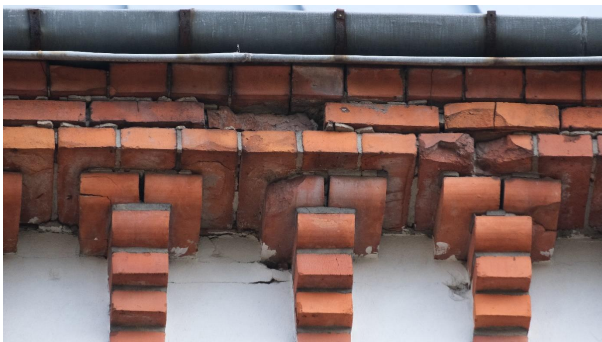
Fot. 9. Zniszczenia gzymsu koronującego Kościół w postaci ubytków i spękań cegieł oraz spoin. Fot. Paweł Wróblewski
