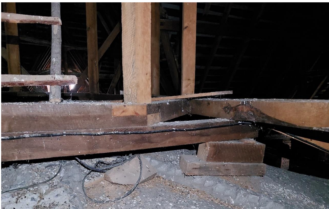
Fot. 16. Amatorskie konstrukcje wsparte o sklepienie Kościoła. Fot. Paulina Zalewska
