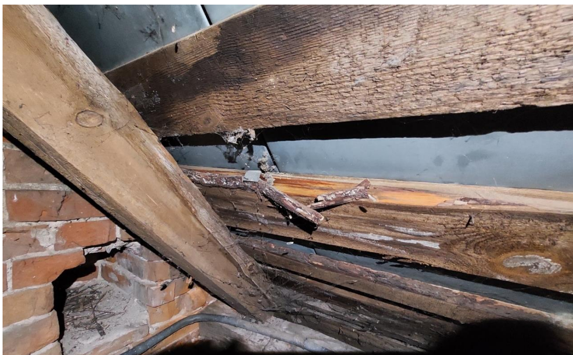
Fot. 25. Jakość (nieokorowane deski) oraz stan zachowania (lokalne zawilgocenie) materiału użytego do deskowania. Fot. Paulina Zalewska
