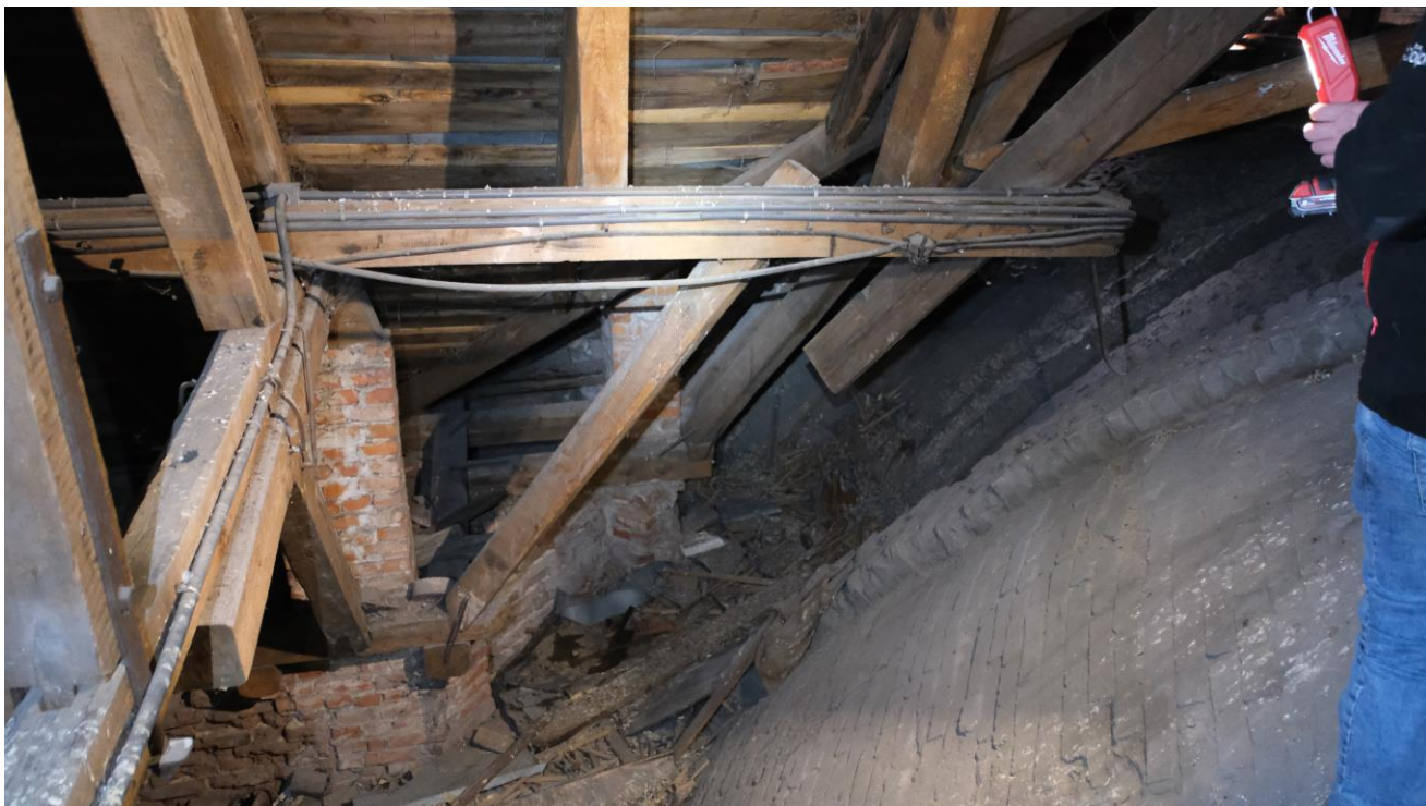
fot. nr 5 widok na podparcie krokwi koszowej na skrzyżowaniu naw z zauważalnym ugięciem wysuniętej wspornikowo płatwi.
