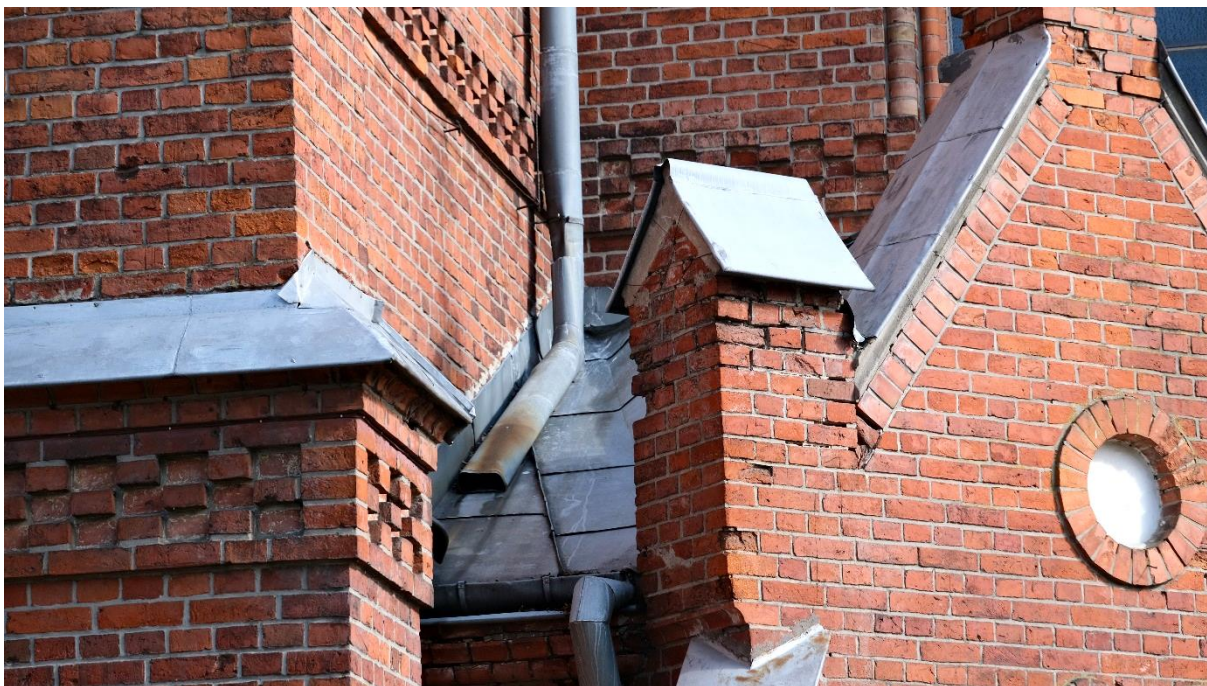
Fot. 11. Miejscowe dysfunkcje systemu odprowadzania wody. Fot. Paweł Wróblewski
