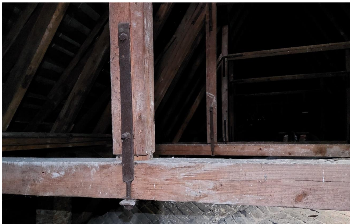
Fot. 18. Konstrukcje więźby dachowej wypięte z zamków ciesielskich. Fot. Paulina Zalewska
