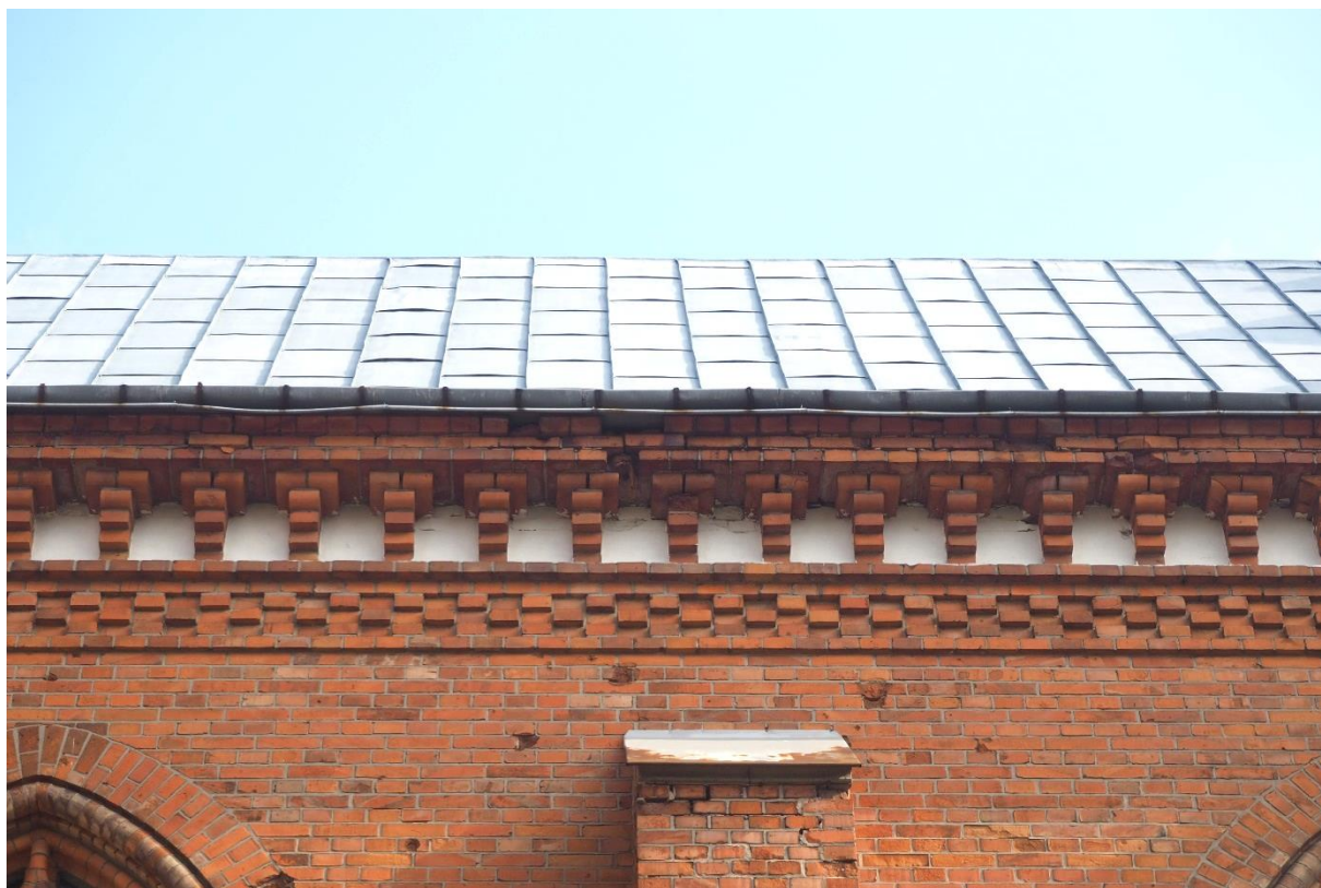
Fot. 8. Stan zachowania ceglanego gzymsu koronującego Kościoła. Fot. Paulina Zalewska
