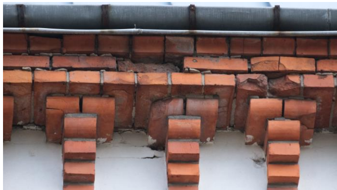
fot. nr 10 uszkodzenia gzymsu koronującego
