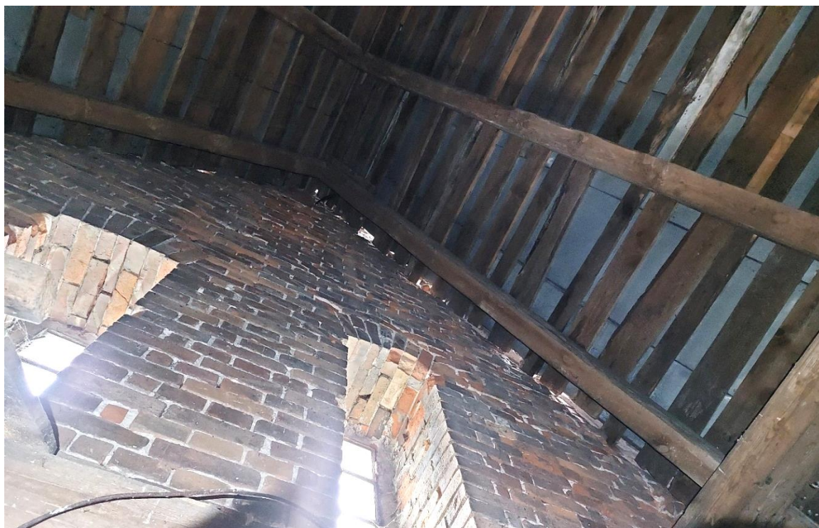
Fot. 20. Nieszczelności na styku szczytu Kościoła i połaci dachowych. Fot. Paulina Zalewska
