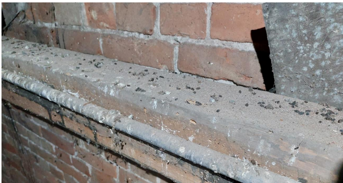
Fot. 22. Otwory wylotowe oraz odchody pozostawione w drewnie po Spuszczelu Pospolitym. Fot. Paulina Zalewska
