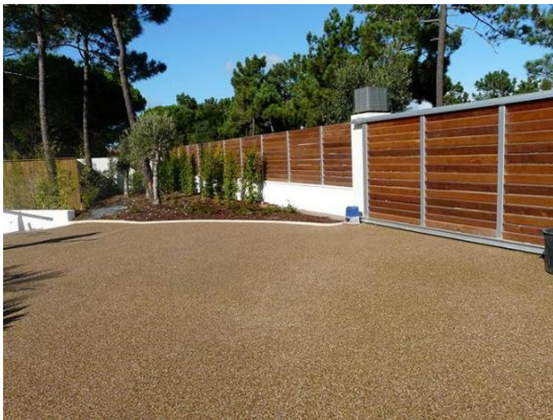
Fot. 36. Zastosowanie nawierzchni „TerraWay®”.
