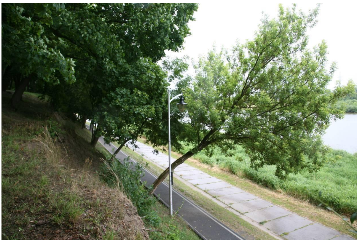
Fot. 23. Teren skarpy, wymagający nasadzeń z roślin umacniających skarpe.
