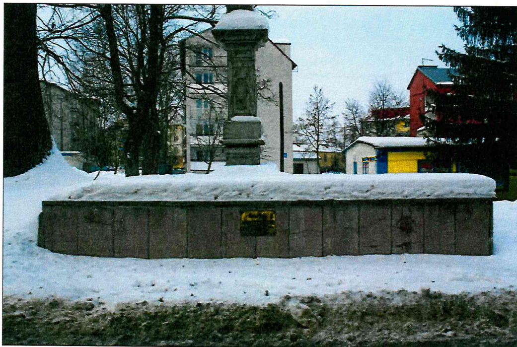
Fot. nr 2. Wyszków, Obelisk Wazów, fragment, stan przed konserwacją, luty 2010r.
