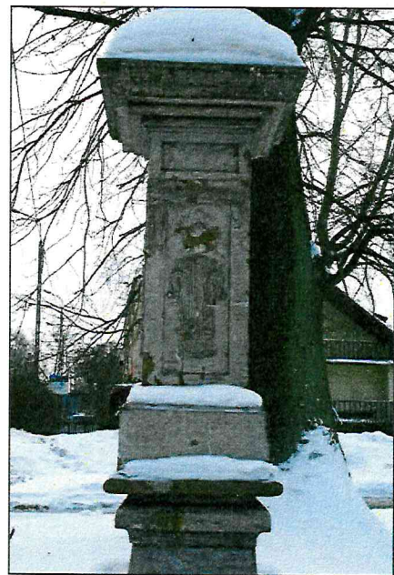
Fot. nr 6. Wyszków, Obelisk Wazów, fragment, stan przed konserwacją, luty 2010 r.
