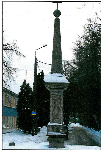
Fot. nr 4. Wyszków, Obelisk Wazów, fragment, stan przed konserwacją, luty 2010 r.
