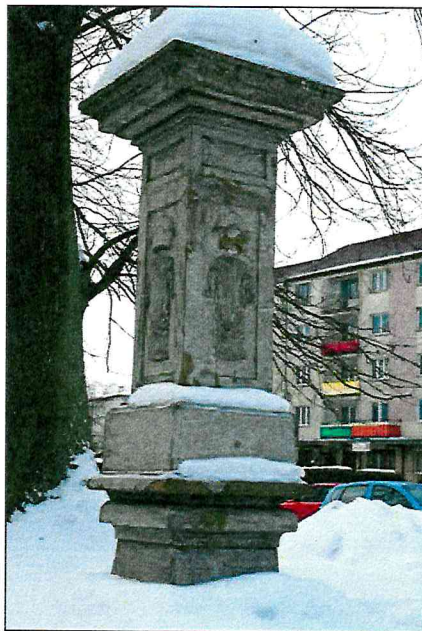
Fot. nr 5. Wyszków, Obelisk Wazów, fragment, stan przed konserwacją, luty 2010 r.
