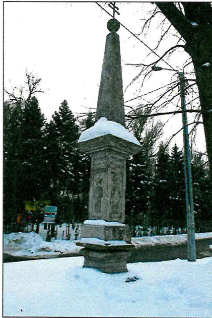
Fot. nr 3. Wyszków, Obelisk Wazów, fragment, stan przed konserwacją, luty 2010 r.
