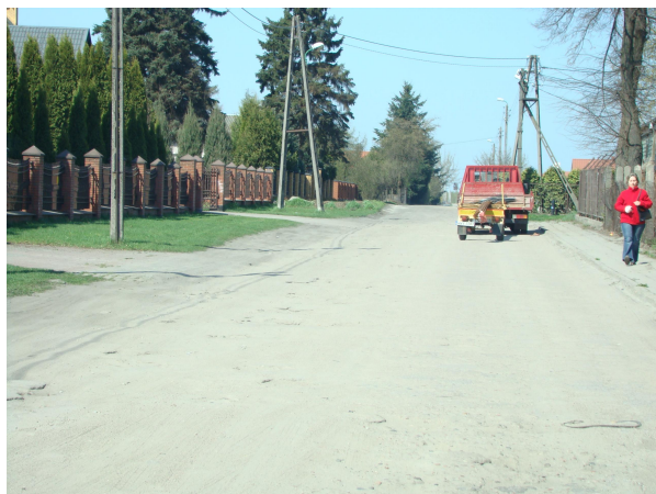
odcinek o nawierzchni z trylinki – od km 0+112 do km 0+207 (ul.Meliorantów)
