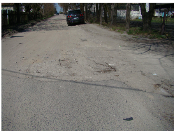
początek odcinka z nawierzchnią z płyt żelbetowych – do rozbiórki
