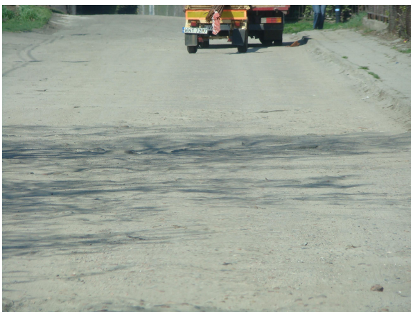
odcinek o nawierzchni z trylinki – od km 0+112 do km 0+207 (ul.Meliorantów)
