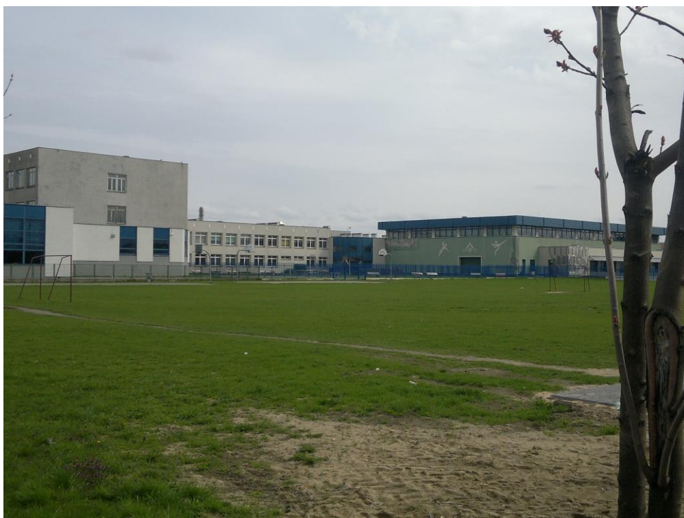
fot. nr 2: elewacja S
