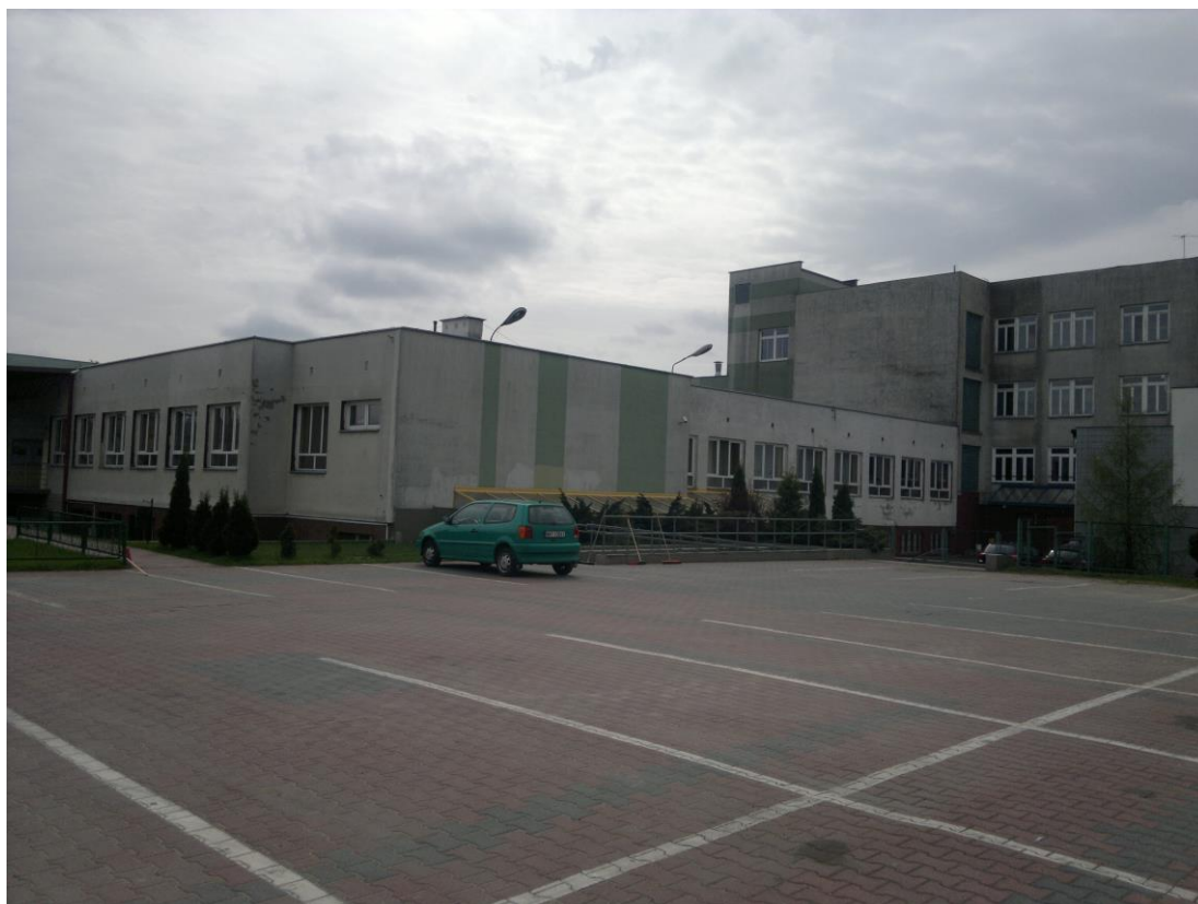
fot. nr 3: elewacja W
