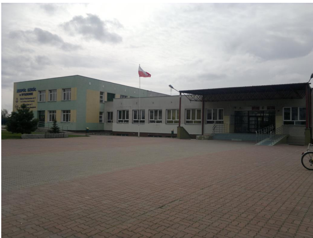
fot nr 1: elewacja N
