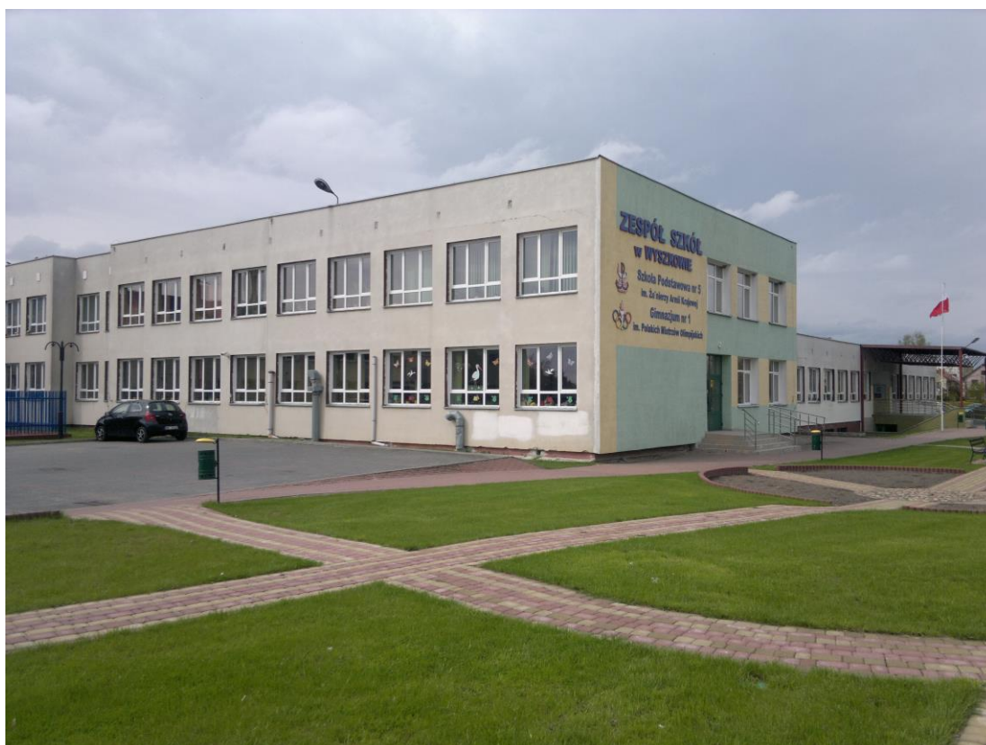
fot. nr 4: elewacja E
