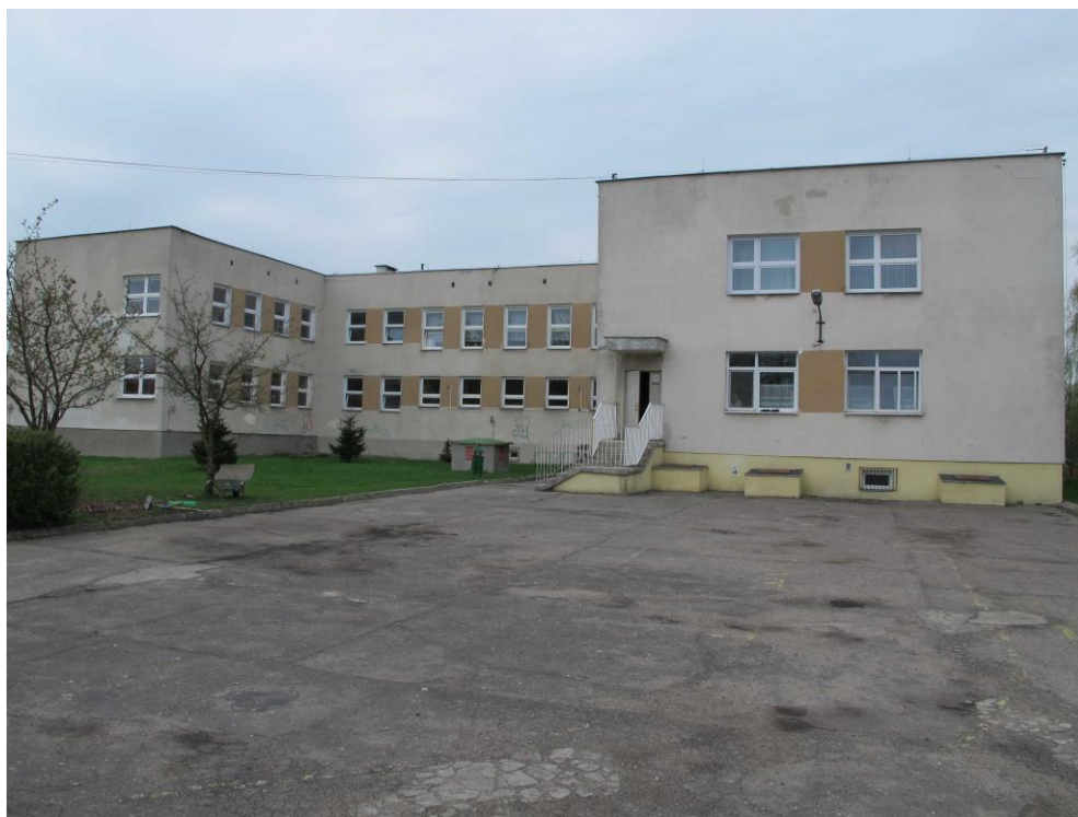
fot. nr 2: elewacja NE
