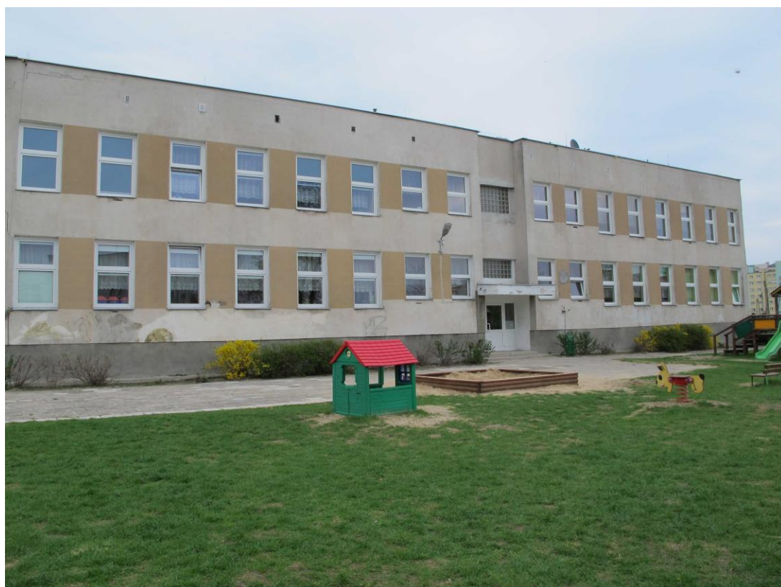
fot. nr 4: elewacja SE
