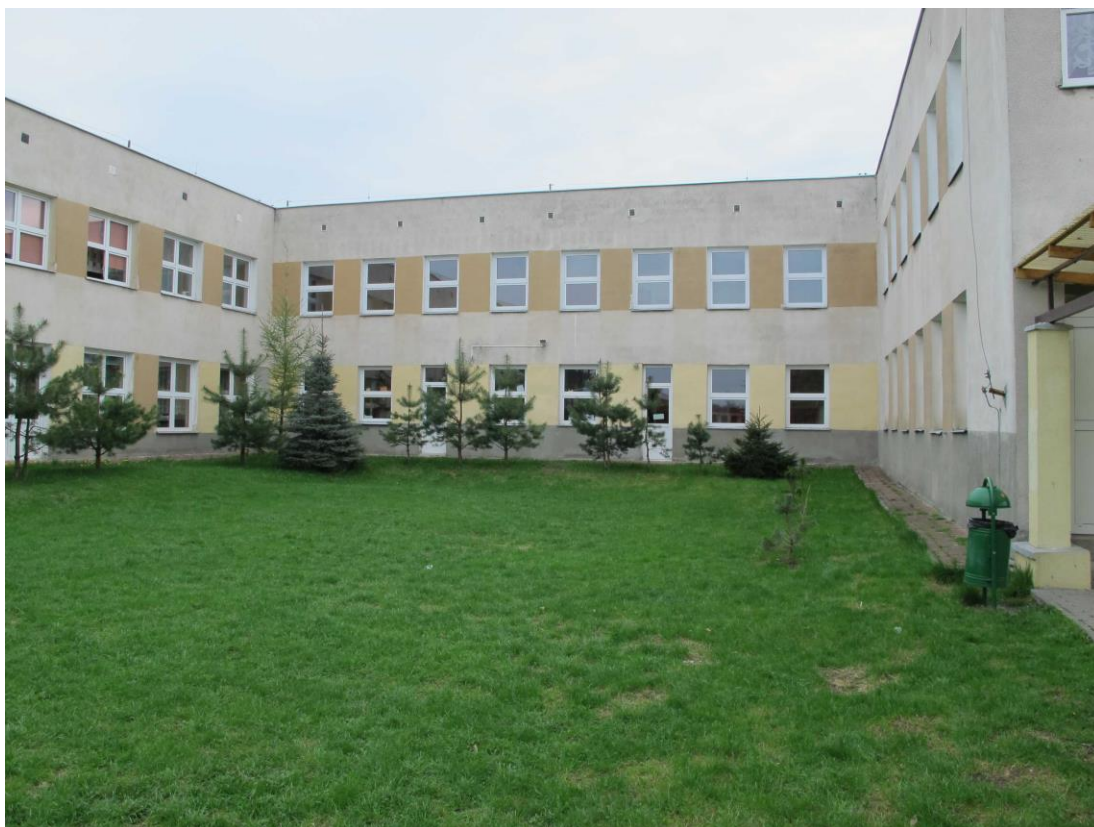
fot. nr 3: elewacja SW
