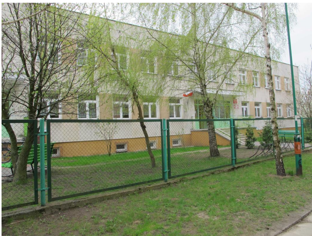
fot nr 1: elewacja NW
