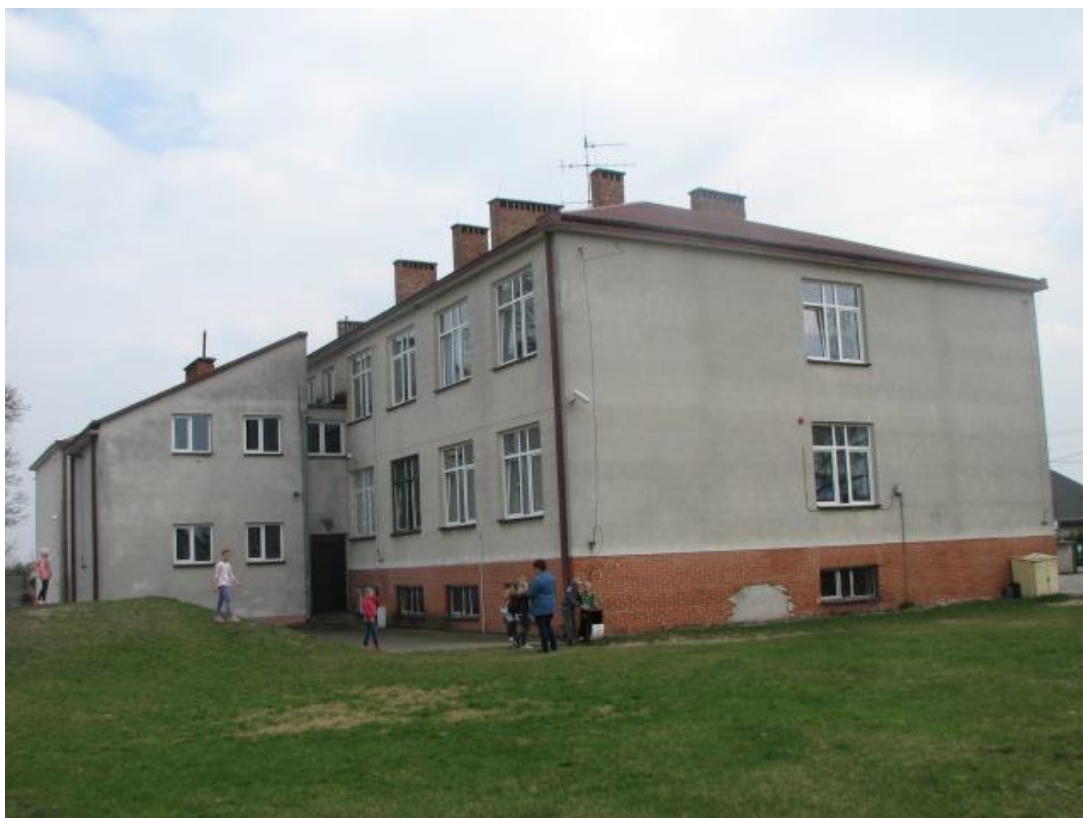
fot. nr 3: elewacja W
