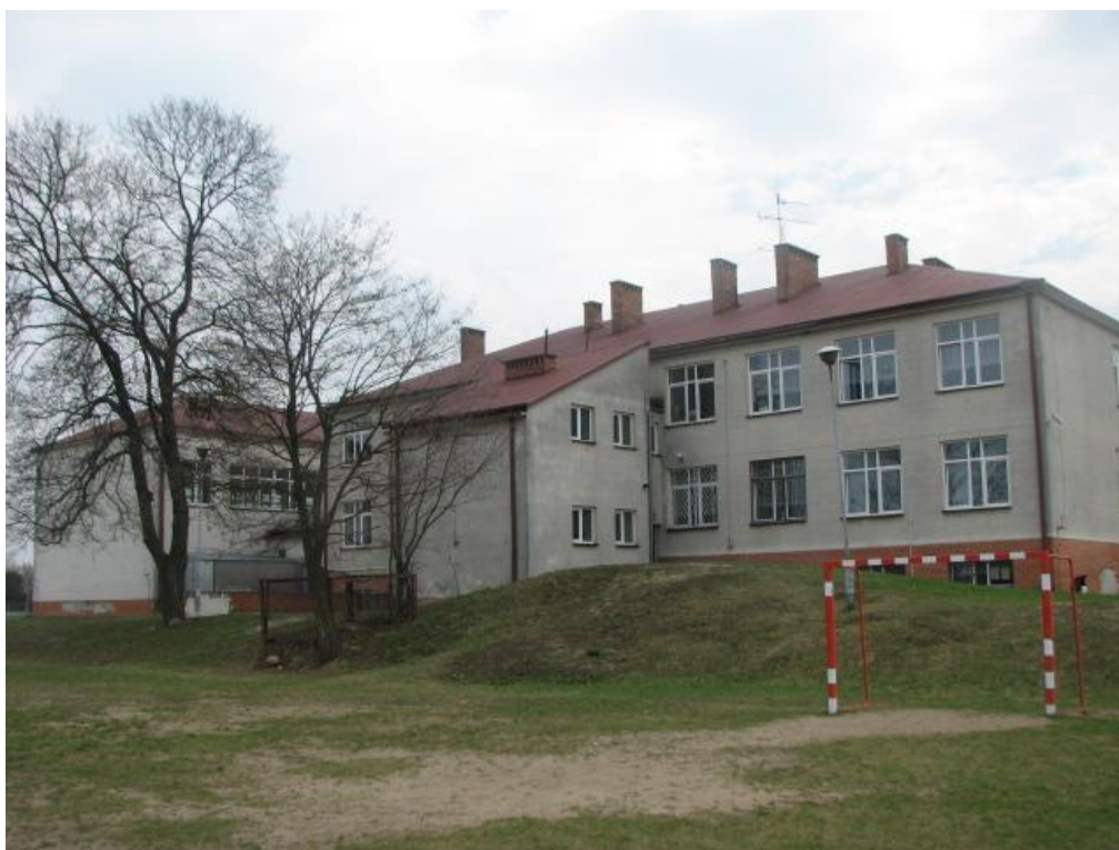
fot nr 1: elewacja N
