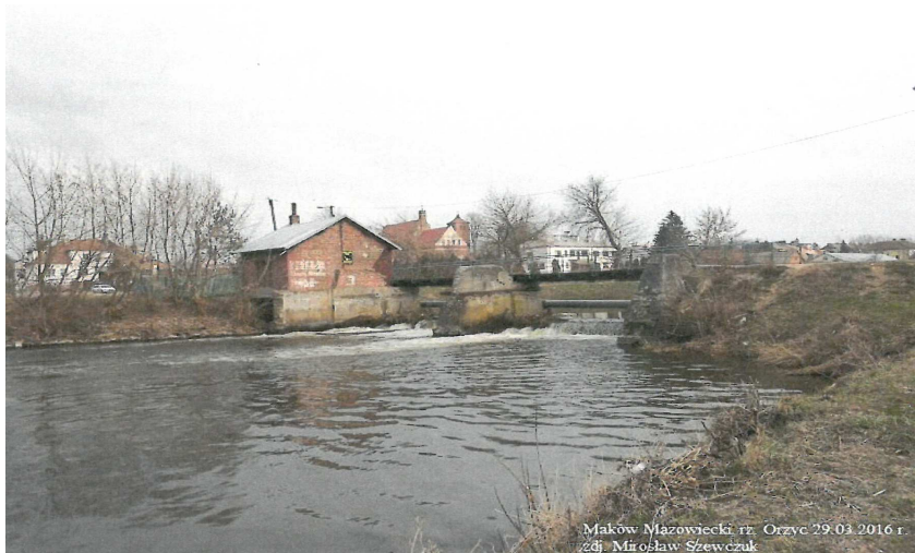
Obiekt byłej elektrowni wodnej, na rz. Orzyc w km. 24+100. Maków Mazowiecki
