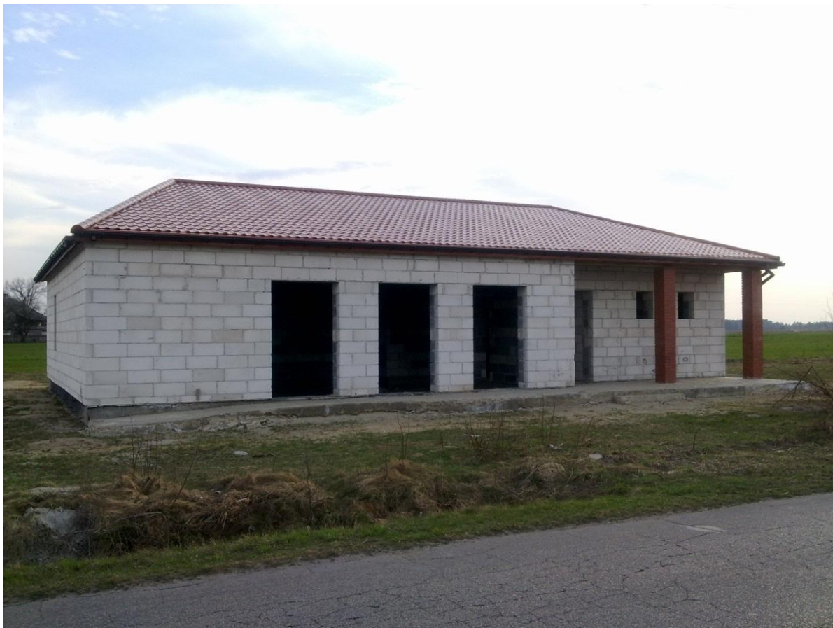
Zdjęcie nr 5. Budynek Świetlicy Wiejskiej.
