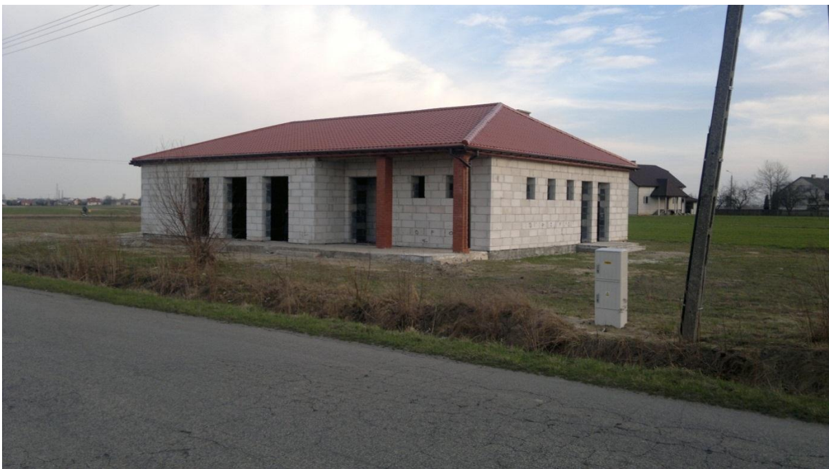
Zdjęcie nr 4. Budynek Świetlicy Wiejskiej.
