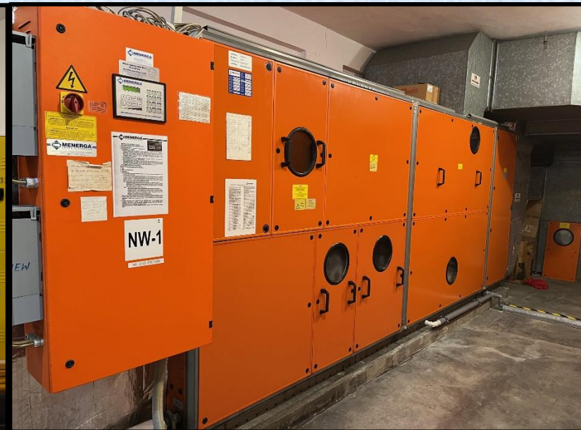
Wymiana wentylatorów odpowiadających za salę basenową
