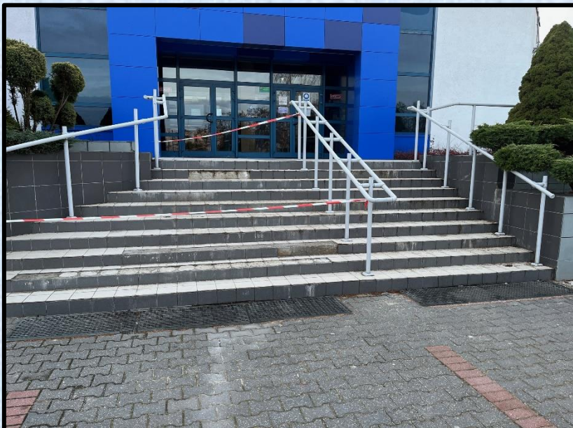
Przebudowa wejścia na pływalnię
