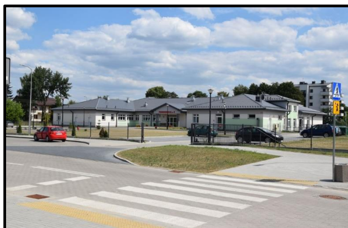
Energooszczędny budynek Przedszkola Nr 2 przy ul. Meliorantów
