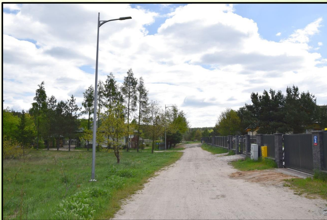
Oświetlenie uliczne w Drogoszewie przy ul. Dobrej
