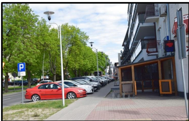
Linia oświetlenia ulicznego przy ul. 11 Listopada w Wyszkanie
