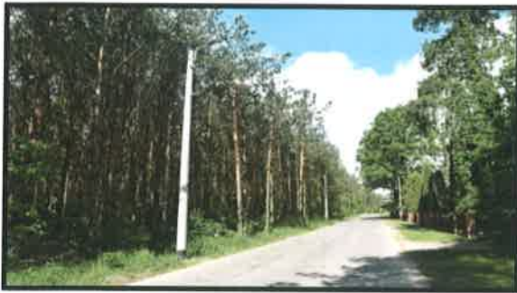
Linia oświetlenia ulicznego przy ul. Przejazdowej w Skuszewie
