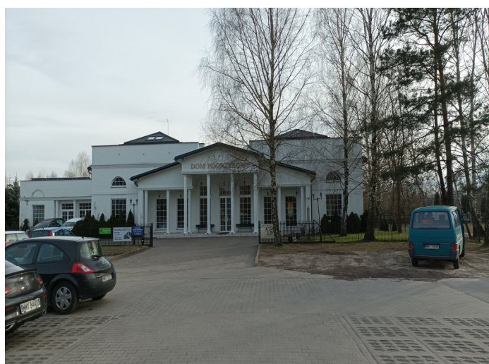
Fot.2. Dom pogrzebowy na obszarze opracowania / ul. Pułtuska 177/
