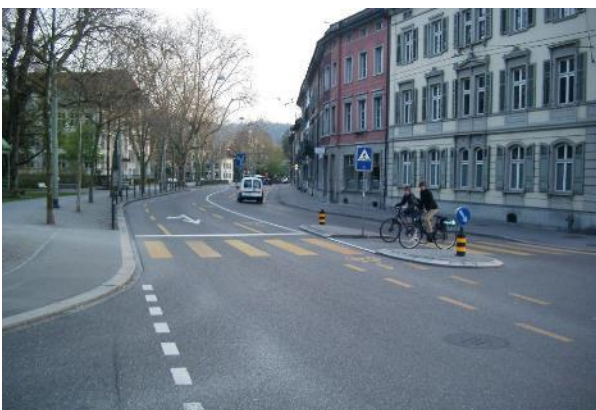
Rys. 0.24 Przykład segregacji ruchu rowerowego na skrzyżowaniu
