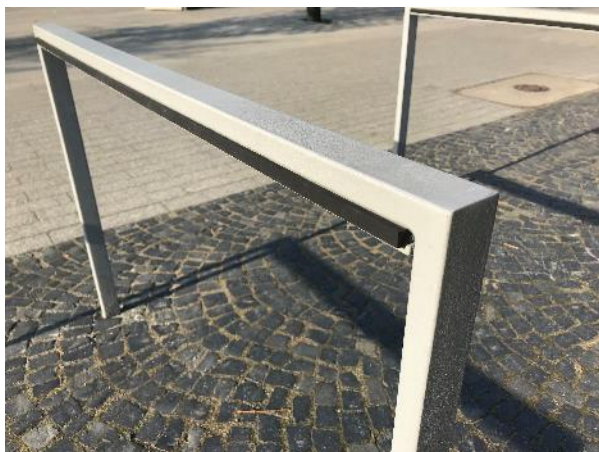
Rys. 0.6 Gumowe zabezpieczenie, umieszczone na stojaku przed, porysowaniem roweru
