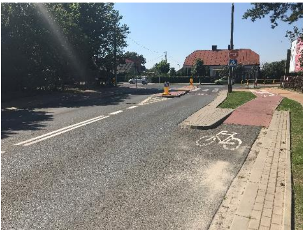
Rys. 0.10 Wprowadzenie ruchu rowerowego z jezdni na ścieżkę przed skrzyżowaniem z drogą o wyższej kategorii
