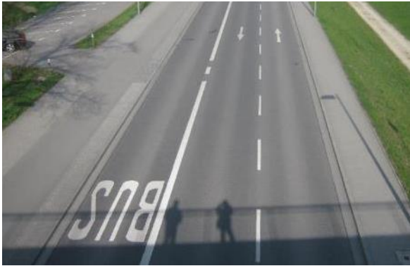
Rys. 0.13. Przykład jezdni z buspasem
